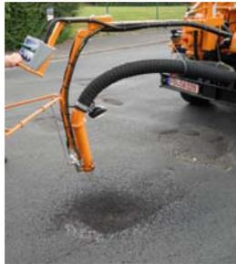
4. Allmähliche Schlaglochausfüllung mit dem bituminierten Splitt
