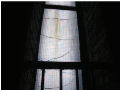
Detail gebrochene Scheiben
