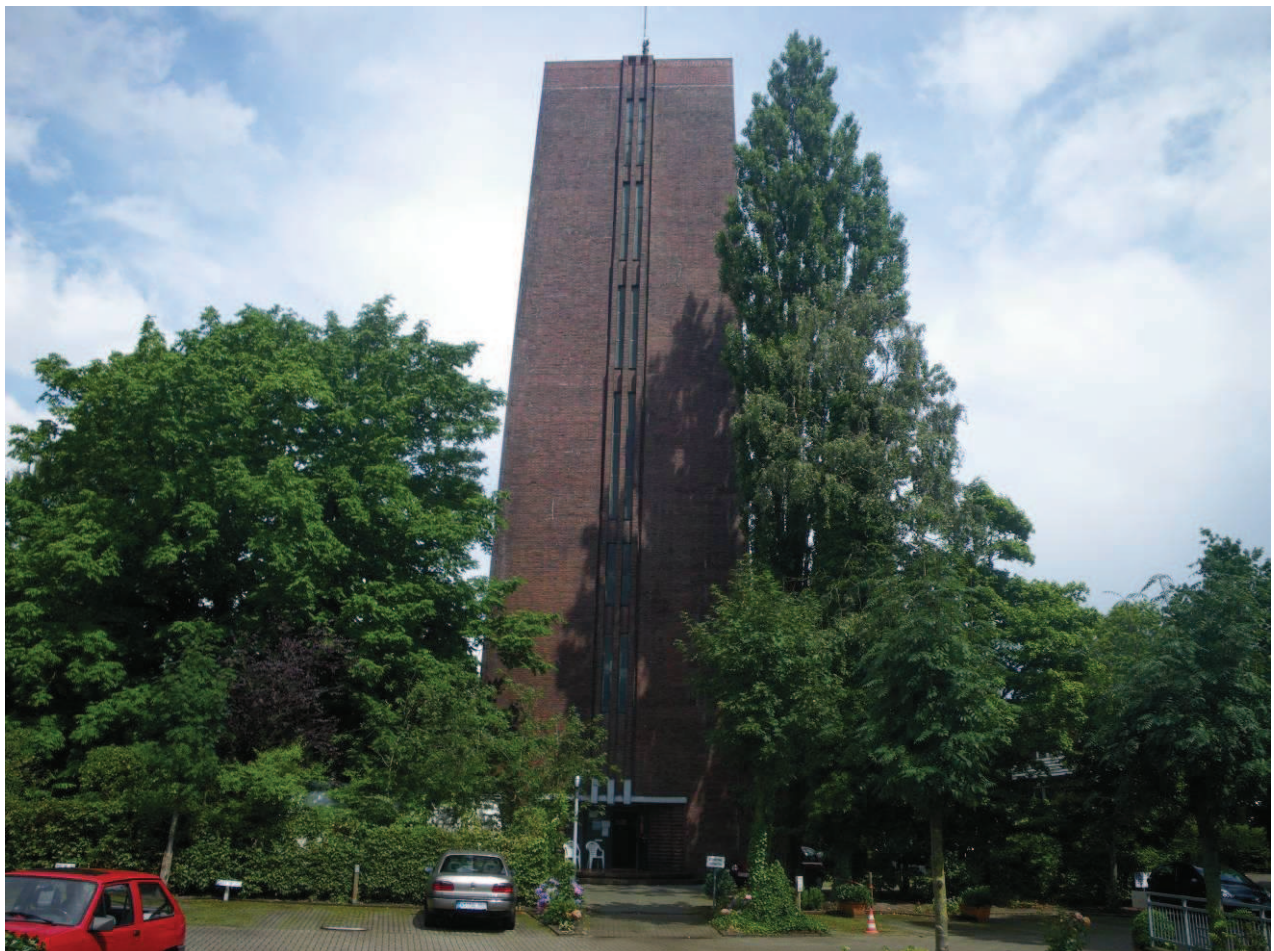
Wasserturm, Ansicht Süd, Juli 2012
