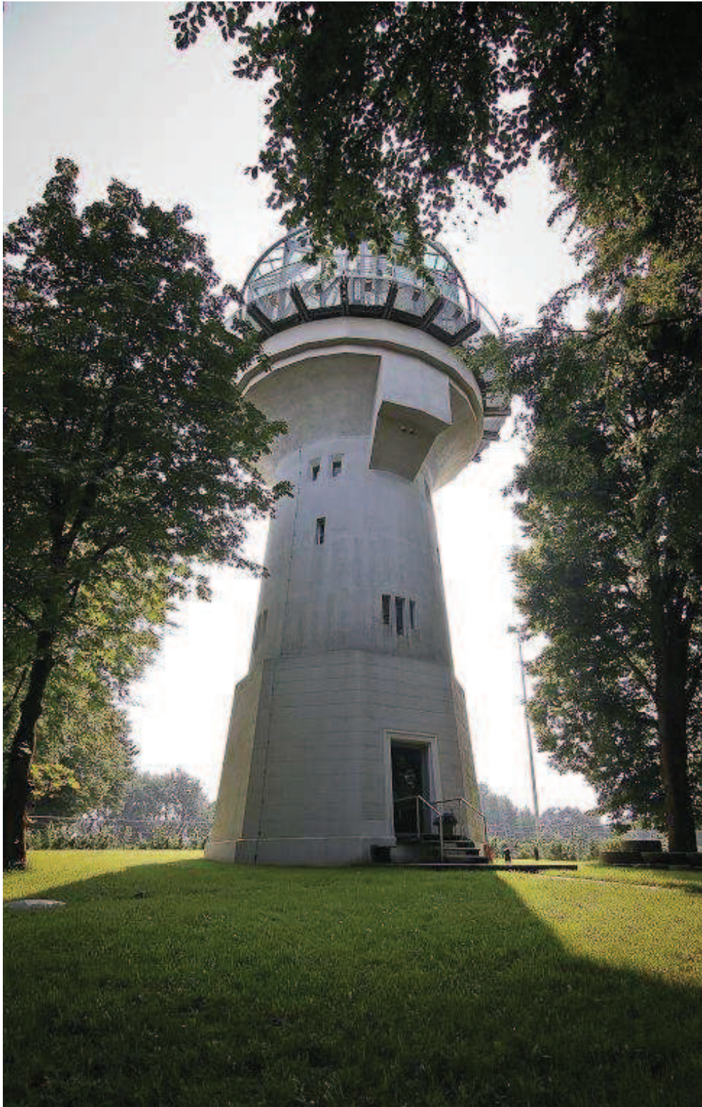
Abbildung 15: Wasserturm in Gräfath
