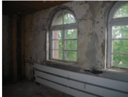
Ansicht Wand West mit entfernten Platten
