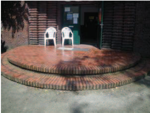
Ansicht Freitreppe der Fassade Süd
