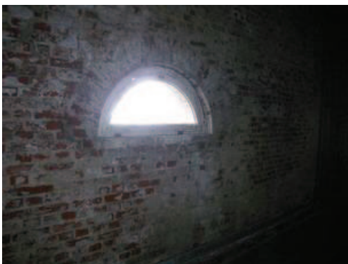
Innenansicht Fenster der Fassade West
