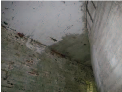
Teilansicht oberste Deckenplatte
