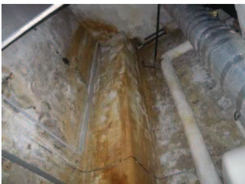
Ansicht Schornstein im EG
