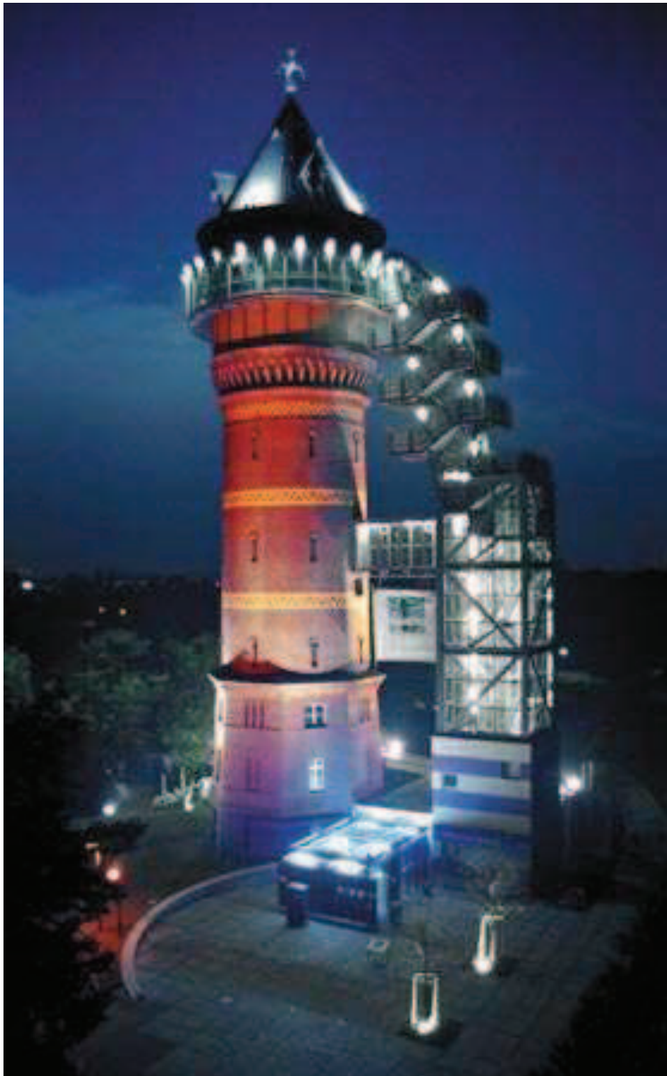
Abbildung 12: Wasserturm in Mülheim / Ruhr
