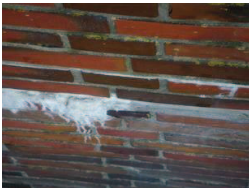
Detail Karbonat-Auswaschung
