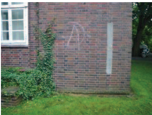
Ansicht Wandfuß Ecke Nordwest
