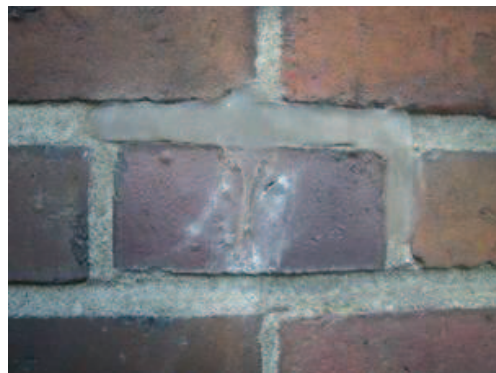
Detail dauerelastische Dichtmasse
