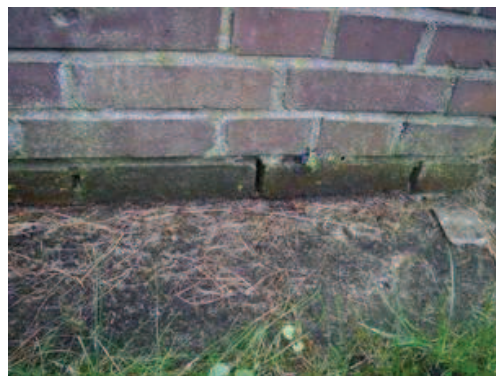
Detail offene Stoßfugen
