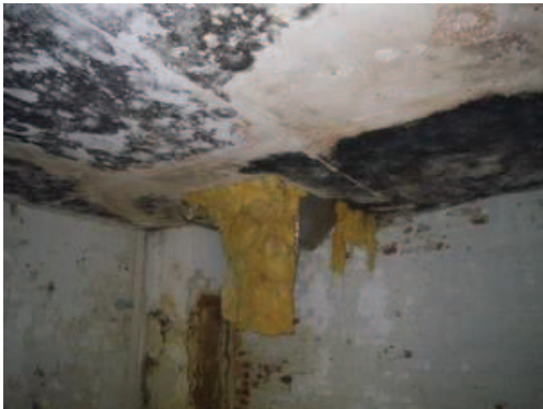
Ansicht Decke im 3. OG
