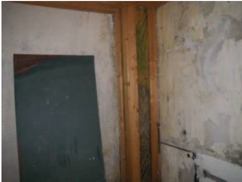
Ansicht ehemals verkleideter Schornstein
