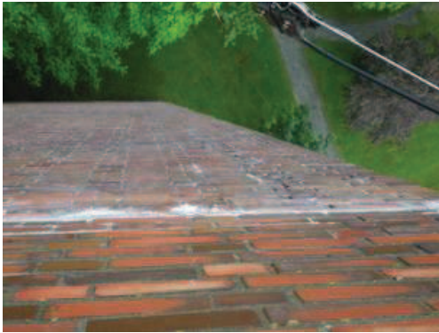
Ansicht obere Fassadenzone Ecke Nordwest
