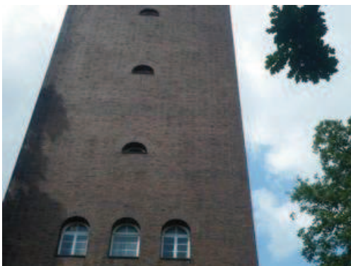
Fassade Ost, mittlere Fassadenzone
