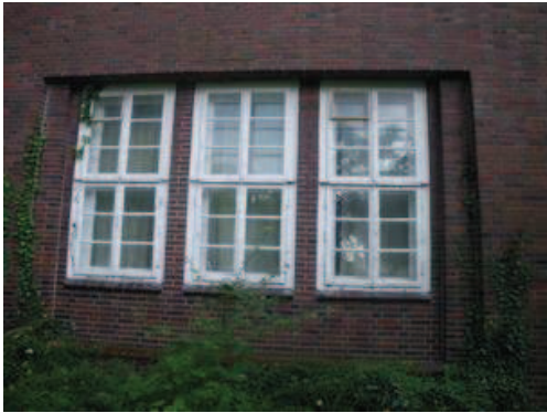
Ansicht Fenster der Fassade Nord
