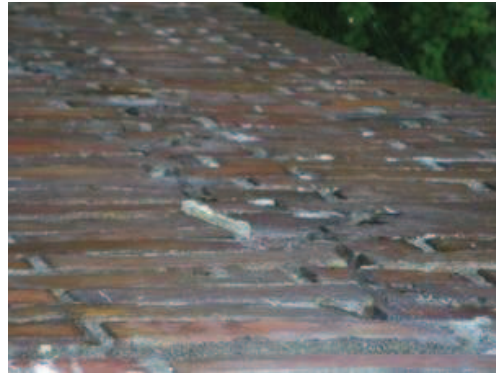
Detail Fugenschäden
