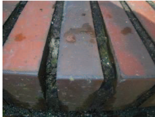
Detail Fugen der Rollschicht
