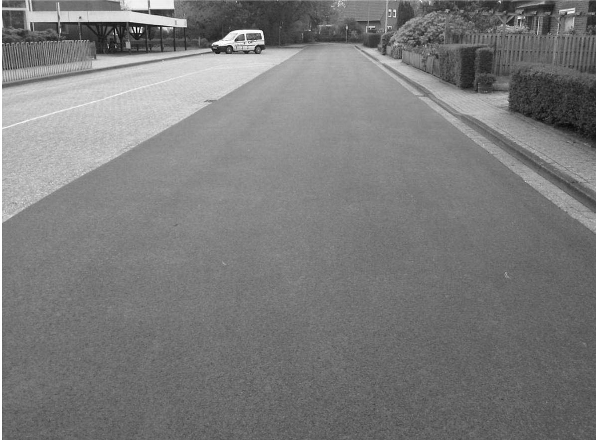
*Pestalozzistraße in Bad Zwischenahn: Die Straße wurde 2012 mit einer neuen Fahrbahndecke versehen. Die Oberfläche ist im Vergleich zur doppelten Oberflächenbehandlung deutlich glatter.*
