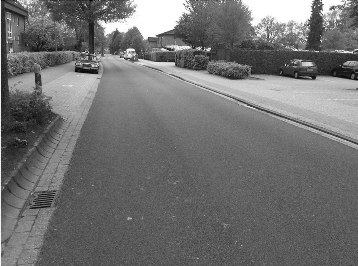
*Ein Beispiel für eine doppelte Oberflächenbehandlung ist der Diekweg (aktuelles Foto), der 2004 auf diese Weise saniert wurde. Die Fahrbahn ist auch heute noch in einem guten Zustand.*
