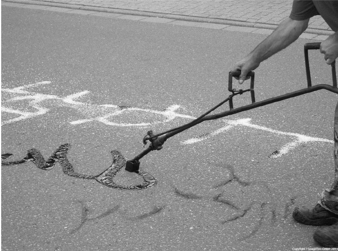
*Beispiel für eine Fugensanierung durch „Patchen“*
