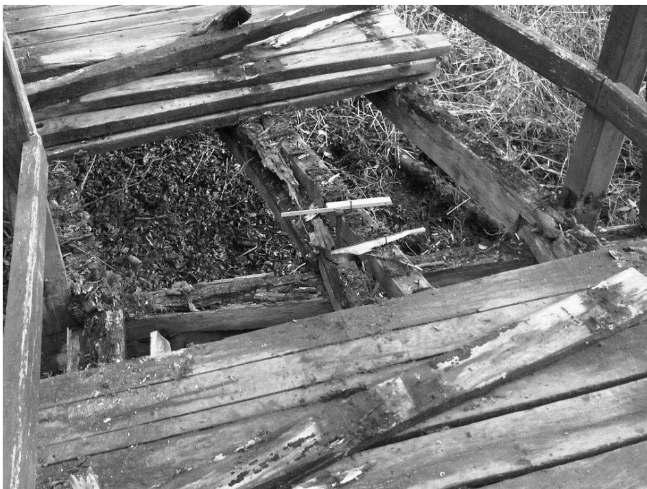
Foto vom 17.2.2014 von einer der drei freigelegten Stellen der Unterkonstruktion
