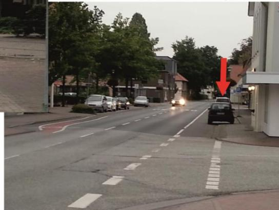
(28) Die Fahrbahn des Kfz-Verkehrs ist in den Straßenabschnitten mit Mehrzweckstreifen ca. 6,50 m breit. Der Mehrzweckstreifen selbst hat je nach Abschnitt eine Breite von 1,60 m bis 1,75 m, zumeist 1,70 m.
