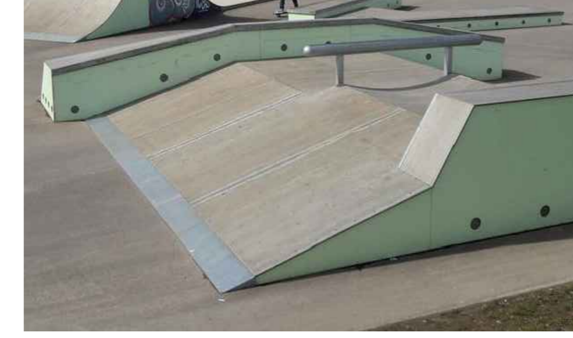
Beispiel für Betonfertigteile auf Metallkorpus: armierte Ortbetonbauweise. Im Bereich Fertigteile eine moderne, nachhaltige Bauweise
